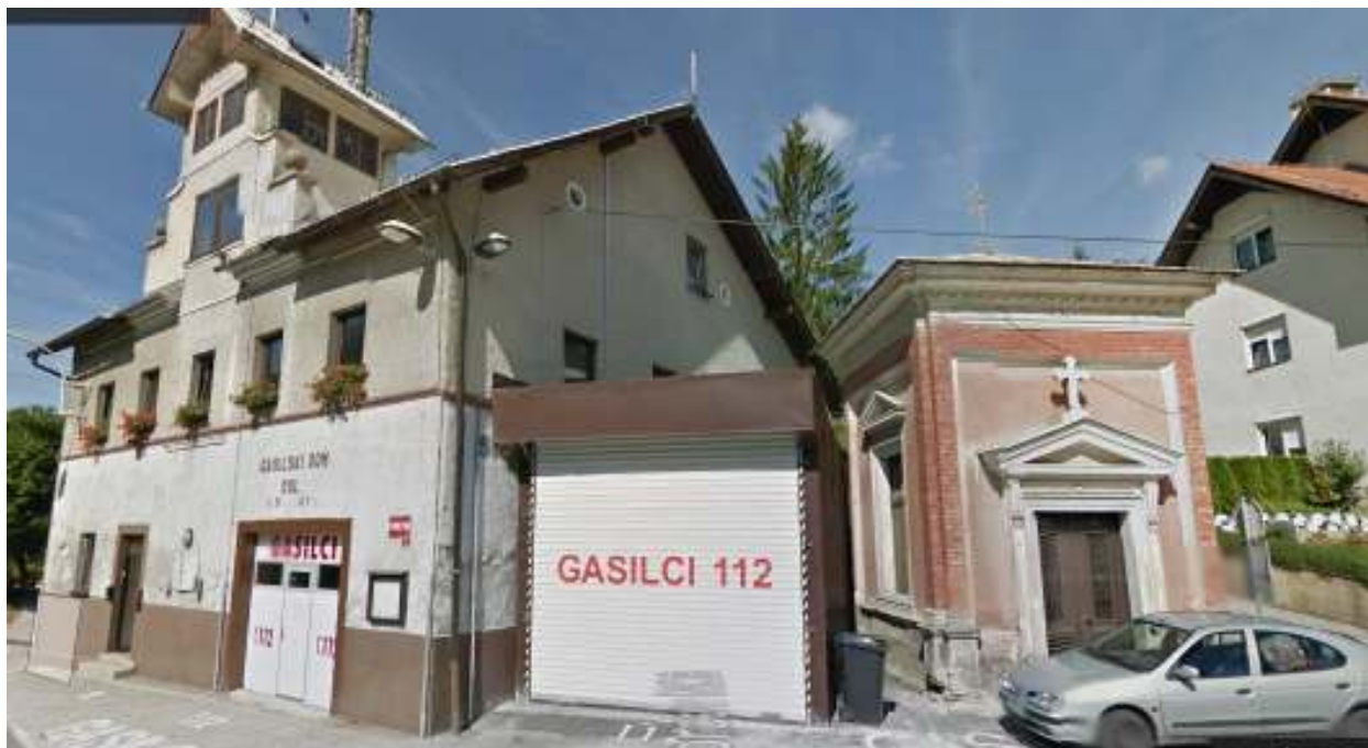
Slika 1: Gasilski dom in cerkveni objekt ob njem
